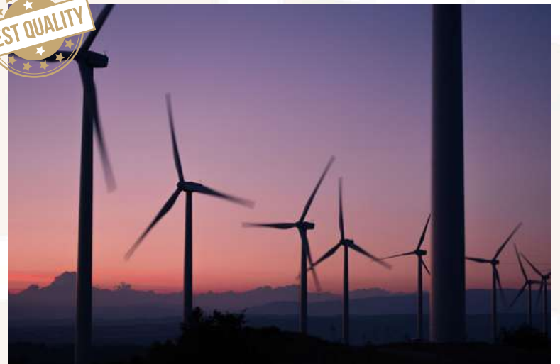
Infraestructuras de 1 º nivel y energías renovables
